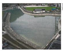
**Bild 5** Schwallausgleichsbecken beim Kraftwerk Gerlos/Zillertal.
