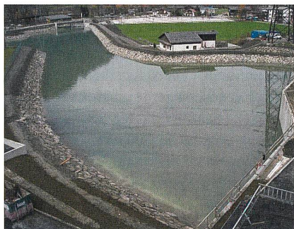
Bild 5 Schwallausgleichsbecken beim Kraftwerk Gerlos/Zillertal.
