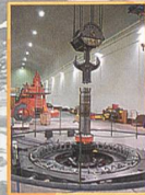
Kraftwerk-Retrofit und Neubau
