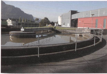
Die EBM realisiert einen Wärmeverbund in Stansstad. Im Bild die dazu genutzte ARA Rotzwinkel.
