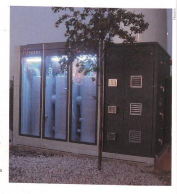
Supraleitender Strombegrenzer im Braunkohlekraftwerk Boxberg. Limiteur de courant à supraconduction à la
