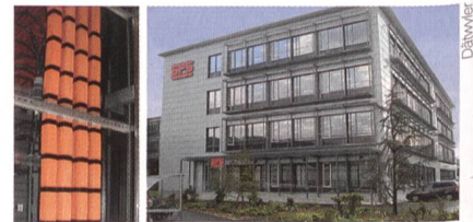
Neues SFS-Gebäude mit Dätwyler-Verkabelung.
