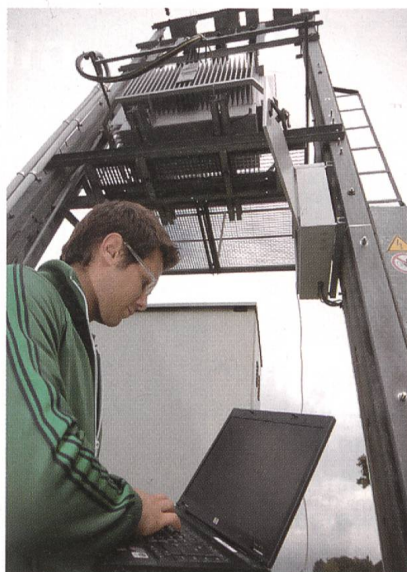
Bild 3 Auslesen des AMIS-Multifunktionszählers vor Ort mit Laptop.
