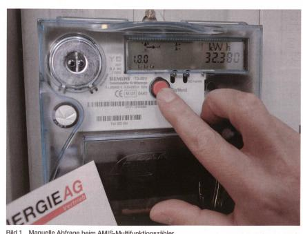
Bild 1 Manuelle Abfrage beim AMIS-Multifunktionszähler.
