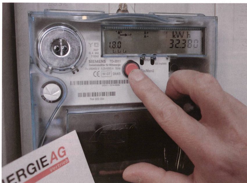
Bild 1 Manuelle Abfrage beim AMIS-Multifunktionszähler.
