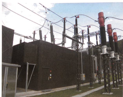
Phasenschiebertrafo im Umspannwerk Tauern.
