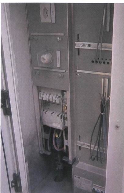
Figure 5 Il ne suffisait plus que de monter le cache, puis de le plomber.
