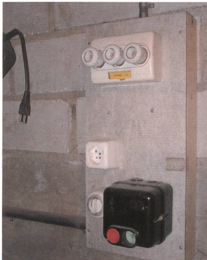
Figure 2 La fiche d'adaptation et le câble de rallonge ont été branchés sur ce tableau de chauffage.
