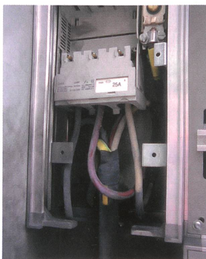
Figure 4 Une fois le raccordement réalisé sur l'élément tripolaire HPC de la cabine, le cache-bornes de l'élément HPC a été monté.
