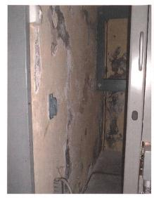
Bild 4 Wandschaden durch Feuchtigkeit im Baukörper einer Transformatorenstation.
