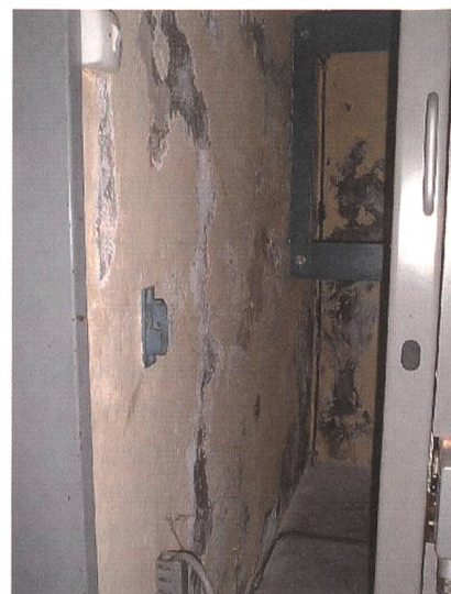
Bild 4 Wandschaden durch Feuchtigkeit im Baukörper einer Transformatorenstation.
