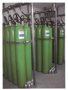
In den Bergeller-Kraftwerken des EWZ sind die bisherigen CO<sub>2</sub>-Löschanlagen mit neuen Argonite-Feuerlöschsystemen von Contrafeu ausgestattet worden.
