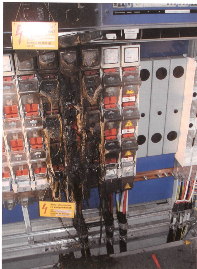
Bild 1 Abgebrannter NHS-Anschluss.
