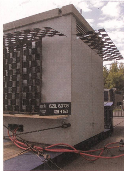
Bild 5 Prüffeld fabrikfertige Station, begehbar, vor «B-Schuss».
