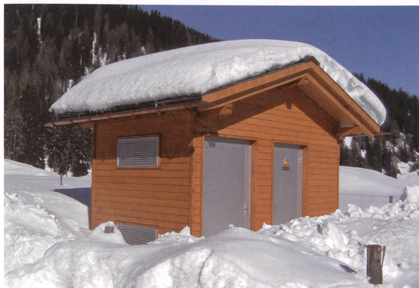
Bild 1 Fabrikfertige Station Typ Dentra mit an örtliche Gegebenheiten angepasster Ausstattung.
