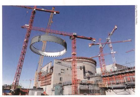
Bild 1 Einsatz eines Elements der inneren Sicherheitshülle auf der EPR-Baustelle in Olkiluoto, Finnland, März 2009.
