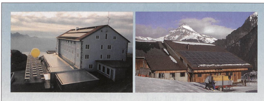
Bild 3 Fotovoltaikanlagen Rigi-Kulm und Gurtellen.
