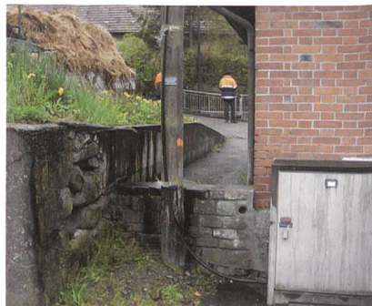
Mehrere Übungen werden 1:1 an einem realen Netz durchgeführt.
