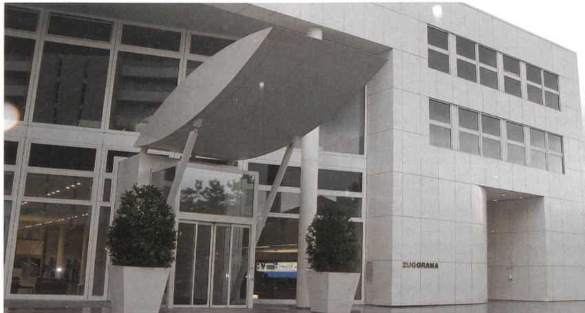
Der imposante Eingang von V-Zug. – L'entrée impressionnante de V-Zug.
