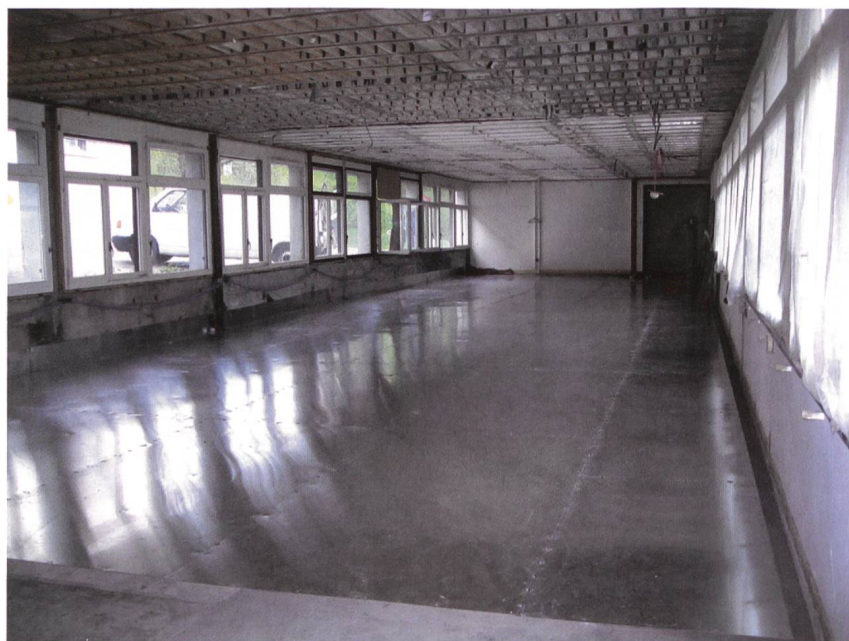
Bild 4 Raum mit fertig montierter Bodenabschirmung vor Einbau der Wände.
