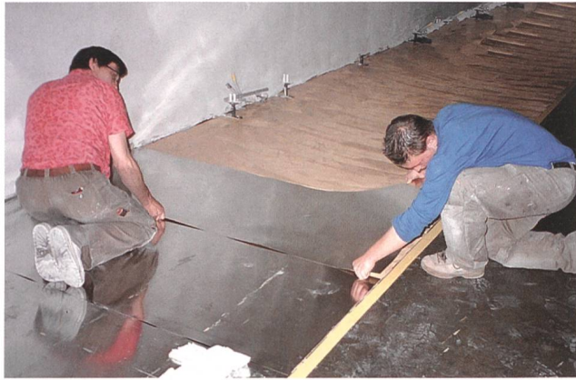
Bild 3 Abschirmplatten werden verlegt.
