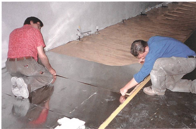
Bild 3 Abschirmplatten werden verlegt.
