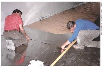
Bild 3 Abschirmplatten werden verlegt.
