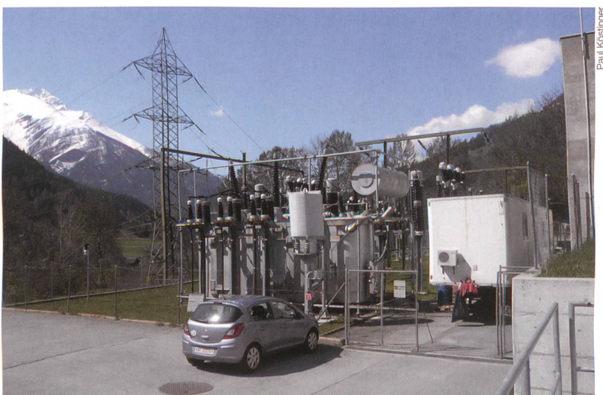
Bild 3 Moderne Ölregenerieranlage mit integrierter Wiederaufbereitung der Fullererde.
