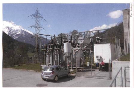
Bild 3 Moderne Ölregenerieranlage mit integrierter Wiederaufbereitung der Fullererde.
