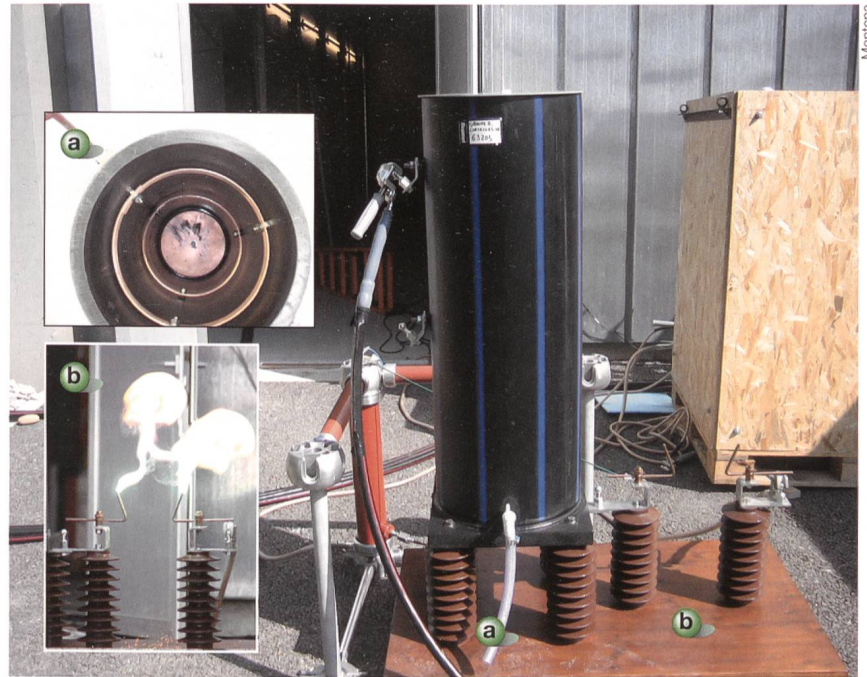
Figure 4 Installation pour générer les défauts, constituée d'une résistance à eau salée (a) et d'un éclateur à cornes réglable (b).
