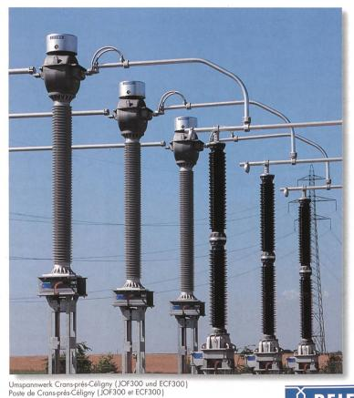
Schweizer Präzision im weltweiten Einsatz für Schutz- und Messzwecke in Stromnetzen bis 525 kV
