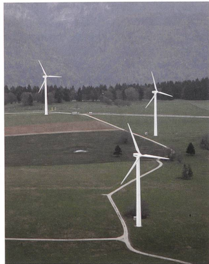
Die Ausbaupläne für den Windpark Mont Crosin liegen nun öffentlich aus.
