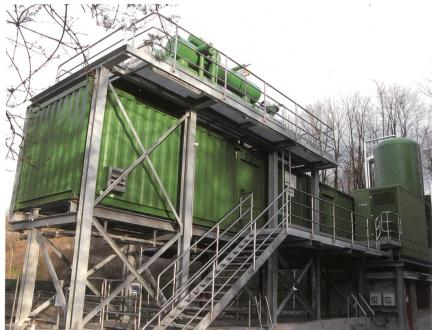
In diesem Container ist die 2,5-MW-Wärmepumpenanlage untergebracht.
