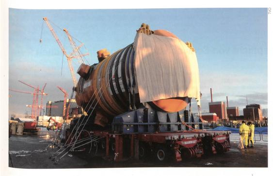
Figure 2 La 3º génération en construction: livraison de la cuve de confinement du réacteur pour le réacteur européen à eau pressurisée (EPR) à Olkiluoto en Finlande. En Asie, plusieurs réacteurs de la 3º génération sont déjà en exploitation.
