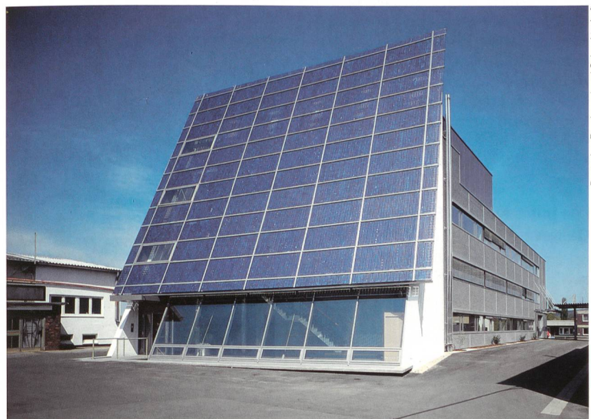
Bild 2 Eine in einem Industriegebäude integrierte FV-Anlage.
