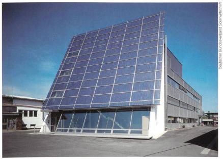
Bild 2 Eine in einem Industriegebäude integrierte FV-Anlage.
