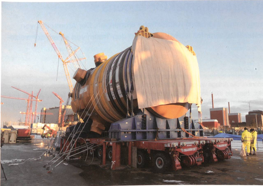
Die dritte Generation im Bau: Anlieferung des Reaktordruckgefäßes für den European Pressurized Water Reactor (EPR) in Olkiluoto in Finnland. In Asien sind bereits mehrere Reaktoren der dritten Generation in Betrieb.
