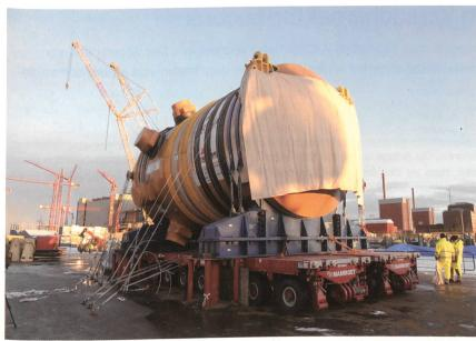
Die dritte Generation im Bau: Anlieferung des Reaktordruckgefässes für den European Pressurized Water Reactor (EPR) in Olkiluoto in Finnland. In Asien sind bereits mehrere Reaktoren der dritten Generation in Betrieb.
