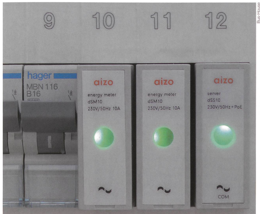
Bild 4 Der DigitalStrom-Server (rechts) kommuniziert via Internet. Die beiden DigitalStrom-Meter bilden mit den eingebauten dSID-Chips die eigentlichen DigitalStrom-Gruppen.
