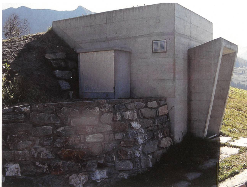
Das Reservoir im Dorf Riein. An der linken Seitenwand wurde im Herbst der Trafo angebracht. Im Innern wird im Frühling die Turbine installiert.
