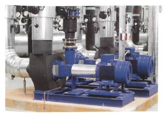
Bild 1 Klassische Motor-Pumpe-Anordnung.
