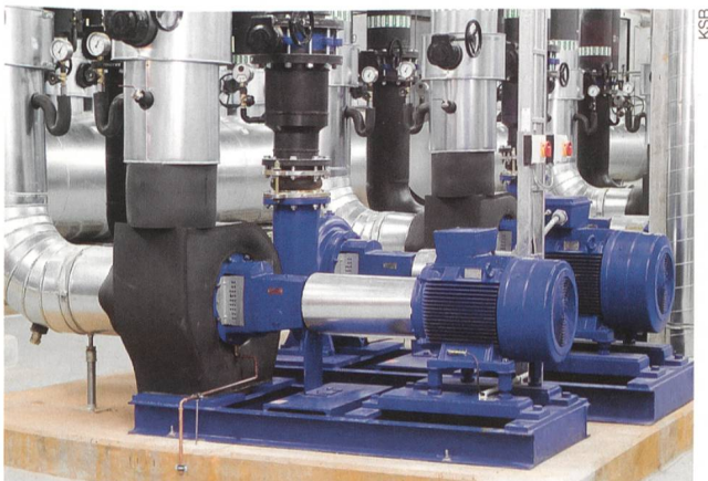
Bild 1 Klassische Motor-Pumpe-Anordnung.
