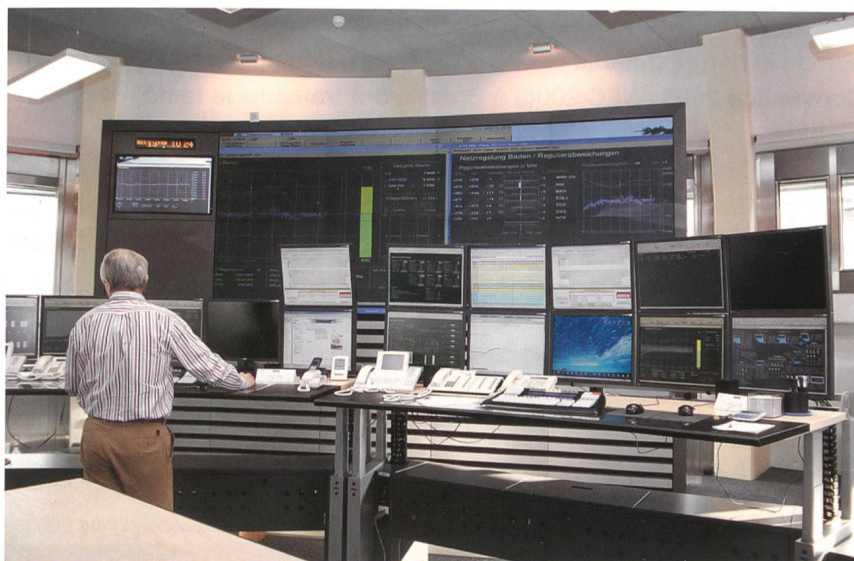
Arbeitsplätze des operativen Kraftwerkeinsatzes mit Grossbildprojektion.
