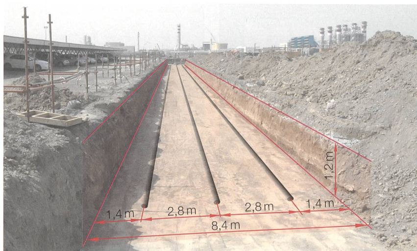
Bild 4 Kabelgraben mit aussergewöhnlichen Dimensionen (Seitenverhältnis Breite/Höhe=7).
