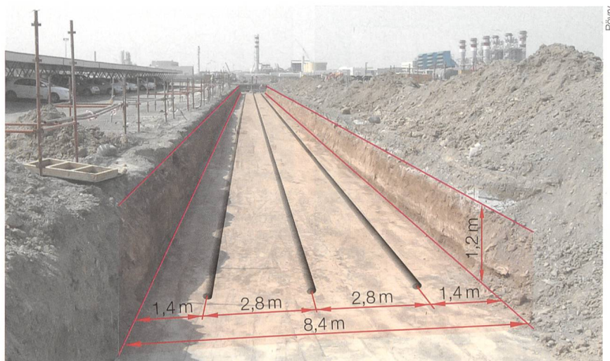
Bild 4 Kabelgraben mit aussergewöhnlichen Dimensionen (Seitenverhältnis Breite/Höhe=7).
