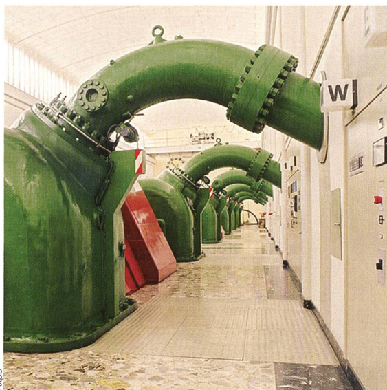
Ansicht Maschinengruppen (grün: Turbine und obere Einlaufrohre; rechts: Schalttafeln mit Maschinensteuerung).
