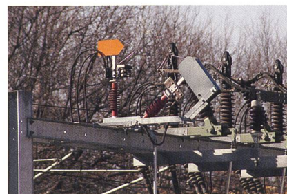
Erdungsschalter im Sternpunkt. Disjoncteur shunt en neutre.
