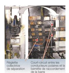
Figure 5 La barrette de raccordement de la réglette de sécurité a provoqué un court-circuit entre les conducteurs polaires.
