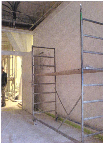
Figure 1 Les profils de plafond sur lesquels le monteur travaillait depuis l'échafaudage roulant se trouvaient sous tension.
