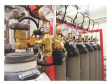
Druckbehälter der HI-FOG-Sprühflutanlage GPU 500 von Contrafeu.
