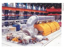
Dieser Generator liefert 2000 MVA – und ist auch nur eine rotierende Maschine.
