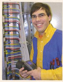
funktionieren: Notlicht, Durchfahrtsbeleuchtung, SOS-Nischen, Fluchtwegbeleuchtungen, alle Steuerungen und Überwachungen inkl. Funk, Teile der Entlüftung (Betriebsräume mit Überdruck) usw. werden durch die USV-Anlage mindestens für 60 min versorgt. Dafür sorgen 204 Zellen mit 490 Ah (400 V Gleichspannung, 240 A).
