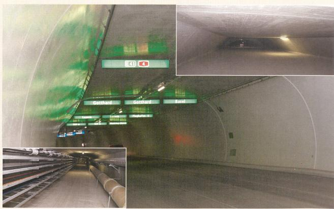
Wenn die Autofahrer ab Mai nächsten Jahres durch den Tunnel flitzen, werden sie kaum realisieren, wie viel Technik sich auch ober- und unterhalb der Fahrbahn befindet. Kleines Bild oben rechts: Auch über der Fahrbahn kann man noch knapp aufrecht gehen und hat zum Beispiel Zugang zu den Abluftklappen. Kleines Bild unten links: Werkleitungskanal unter der Fahrbahn. In der Westumfahrung Zürich wurden etwa 25000 Kabel mit einer Gesamtlänge von ca. 3500 km verlegt.
