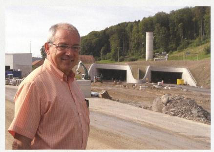
Zwischenhalt auf dem Weg zum Üetlibergtunnel. Roland Röllin vor dem Portal des Islisbergtunnels. Gut sichtbar der Kamin, über den im Brandfall der Rauch ins Freie befördert würde. Der Islisbergtunnel wird im November 2009 dem Verkehr übergeben und führt via Knonaueramt in die Zentralschweiz.
