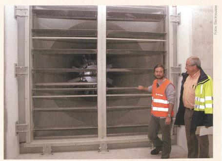
Oben: Fototermin vor einem der mächtigen Axialventilatoren in der Lüftunszentrale Reppischtal, die im Brandfall den Rauch durch den Tunnel (unten) via Kamin ins Freie befördern.
