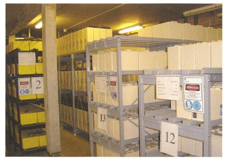
Bild 4 Akkumulatoren-Raum in einem Industriebetrieb.
