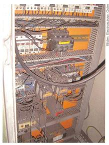
Bild 6 Schaltgerätekombination einer Maschinensteuerungsanlage.
