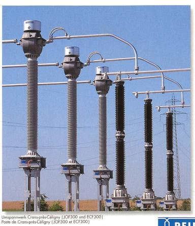
Schweizer Präzision im weltweiten Einsatz für Schutz- und Messzwecke in Stromnetze bis 525 kV
