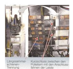
Bild 5 Die Anschlussfahnen der Sicherungsleiste erzeugten einen Kurzschluss zwischen den Polleitern.
