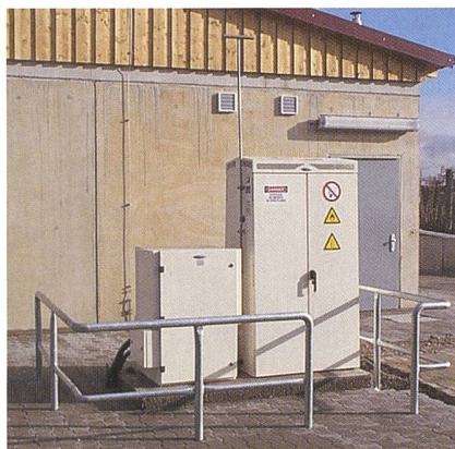
Bild 7 Brennstoffzellensystem im Freien installiert.
