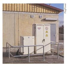
Bild 7 Brennstoffzellensystem im Freien installiert.
