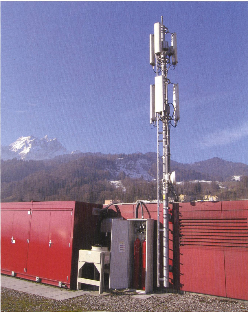
Bild 3 Installation der Mobilfunkbasisstation und USV mit Brennstoffzelle auf dem Dach der Hochschule Luzern.
