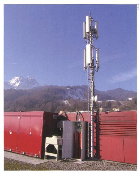
Bild 3 Installation der Mobilfunkbasisstation und USV mit Brennstoffzelle auf dem Dach der Hochschule Luzern.
