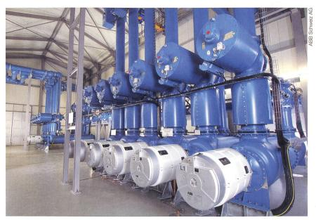
Bild 1 420 kV gasisolierte Schaltanlage der EnBW Transportnetze AG in Metzingen.
