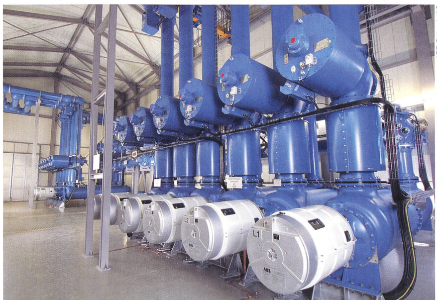
Bild 1 420 kV gasisolierte Schaltanlage der EnBW Transportnetze AG in Metzingen.
