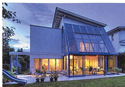
Rund 30% des Stroms für den Verbrauch des Einfamilienhauses in Langenthal erzeugt der Wintergarten.
