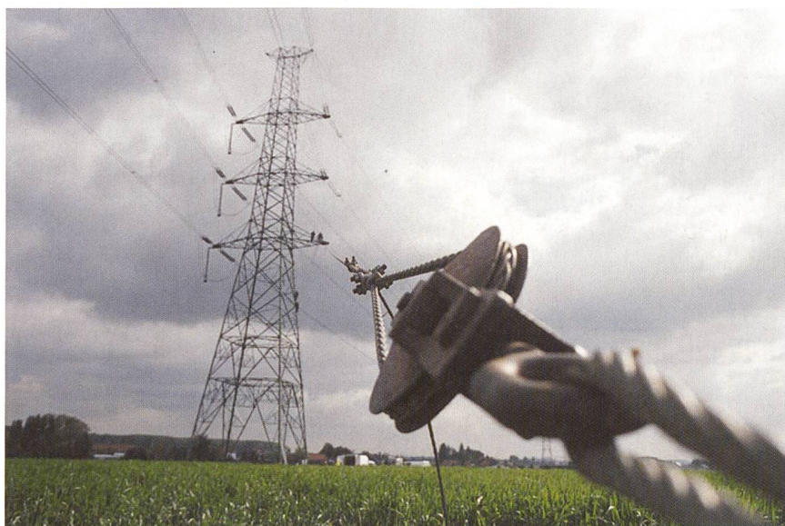
Interconnexion France-Belgique: Déroulage de câble sur la ligne 400 000 V Avelin-Avelghem (Nord).
