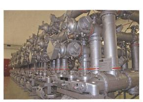
An der gasisolierten 150-kV-Schaltanlage des Unterwerks Zeughaus in Zürich wurden bei der Diagnose 90 Messungen durchgeführt.
