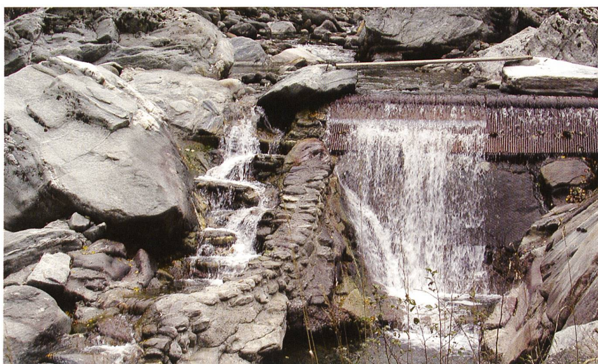
Wasserfassung mit Fischtrappe in der Saltina für Wasserwasserturbiniierung in den Zentralen Wickertwald in Brig-Glis.
