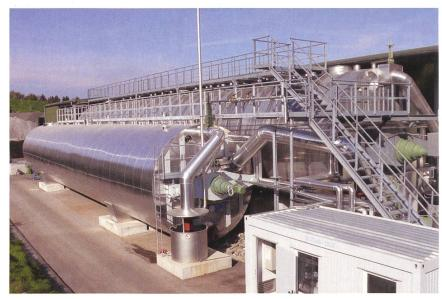
Bild 2 Fermenter in paralleler Anordnung.
