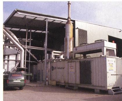
Bild 6 Kompakte Containeranlage mit Gasmotor-Generatoreinheit.
