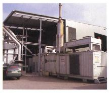
Bild 6 Kompakte Containeranlage mit Gasmotor-Generatoreinheit.
