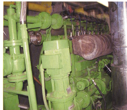
Bild 5 Teilansicht Gasmotorkopf mit Zündkerzen und Abgassammler.
