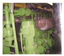
Bild 5 Teilansicht Gasmotorkopf mit Zündkerzen und Abgassammler.
