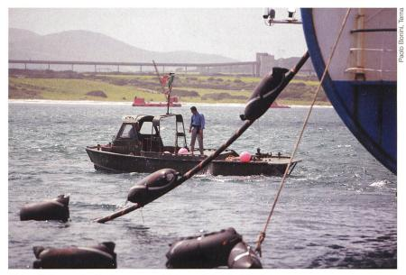
Bild 4 Verlegung des Hochspannungsgleichstromkabels im Mittelmeer.
