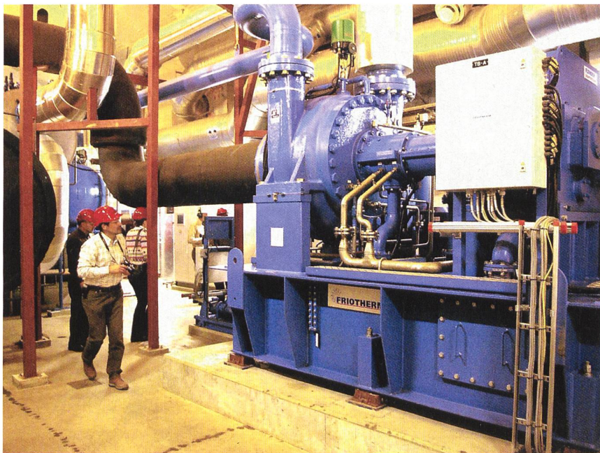
Bild 10 18,4-MW-Wärmepumpe der Viken Fjernvarme.
