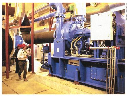
Bild 10 18,4-MW-Wärmepumpe der Viken Fjernvarme.
