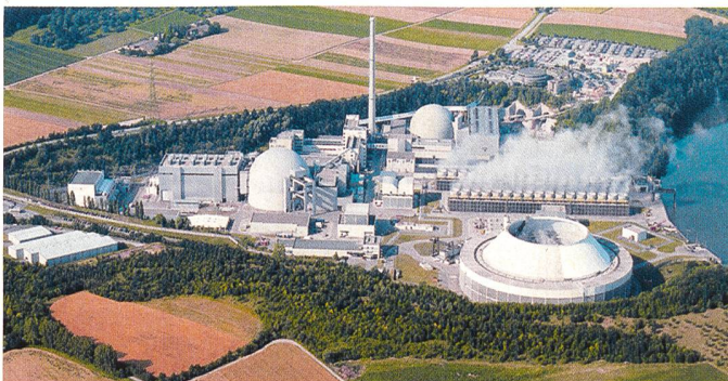
Deutschlands jüngster Reaktor, Block 2 des KKW Neckarwestheim, besitzt einen Hybridkühlturm (vorne rechts).
