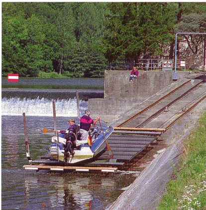
Bild 1 Transport von Booten und Personen in einem Flusskraftwerk.
