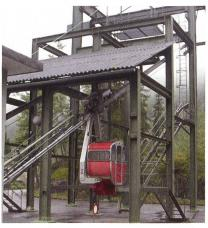
Bild 4 Seilbahn als Zufahrt zu einer Staumauer.
