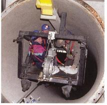
Bild 2 Windenbahn zur Kontrolle der Druckschachtrohre
