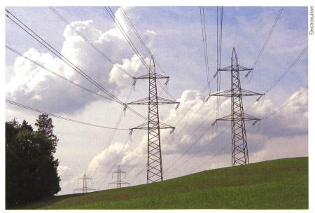
Bild 1 Durchhang von Hochspannungsleitungen.
