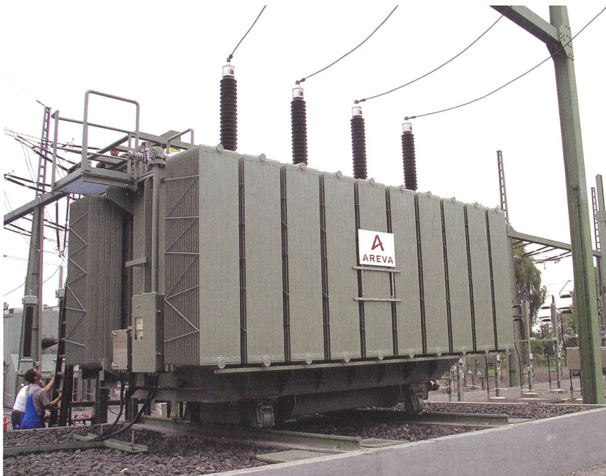
Bild 2 Hermetischer Leistungstransformator.
