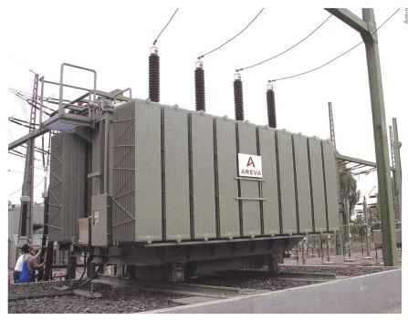
Bild 2 Hermetischer Leistungstransformator.
