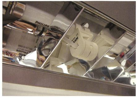
Bild 10 Die Helligkeitssensoren sind direkt in die Leuchten eingebaut: Kein Bereitschaftsverbrauch mehr, sobald das Licht ausgeschaltet wird!
