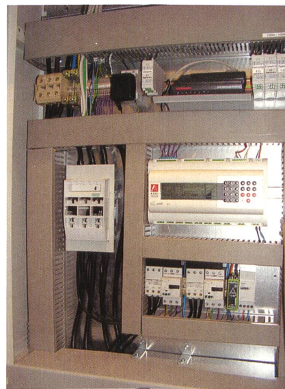
Bild 5 Ankommende Einspeiseleitung der öffentlichen Versorgung in der NS-HV, Übergang auf TN-S-System.
