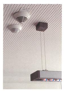
Bild 9 Jeder Raum verfügt über einen Bewegungssensor und einen Rauchmelder.
