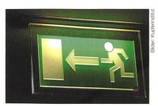
Bild 12 Sorgenkind in Wartung und Betriebskosten: Fluchtwegbeleuchtung.
